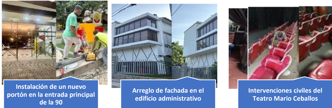
Ilustración 14. Obras intervenidas en la Universidad
